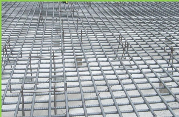
驚異の基礎配筋
